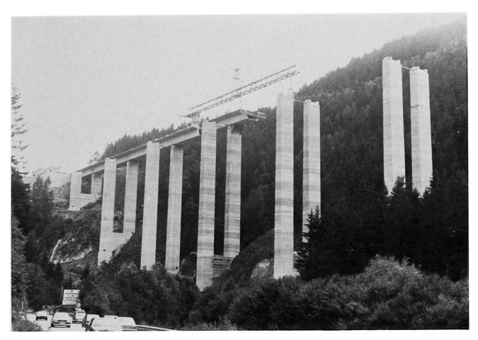
Bild 3 Montage der Brückenfertigteile (Segmente)
