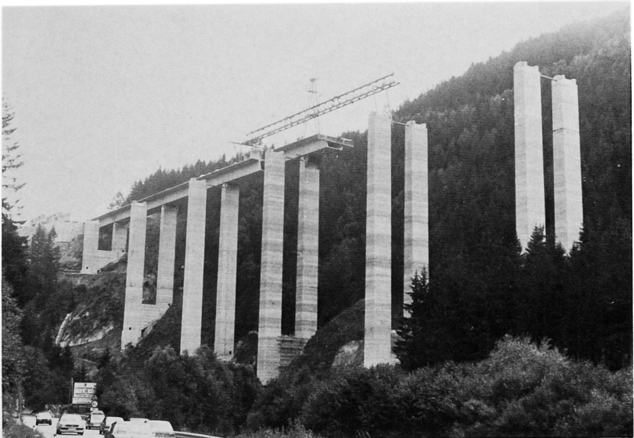
Bild 3 Montage der Brückenfertigteile (Segmente)
