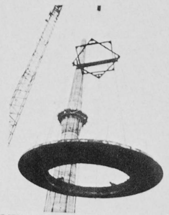
MONTAGE DE LA PLATE-FORME
