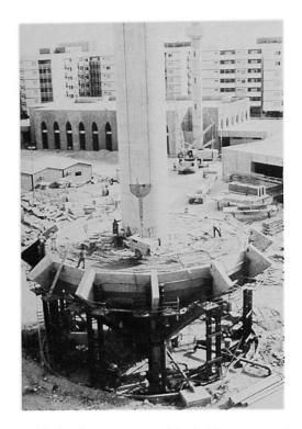
Bild 8 Der Hochbehälter nach Abschluß der Betonierarbeiten
