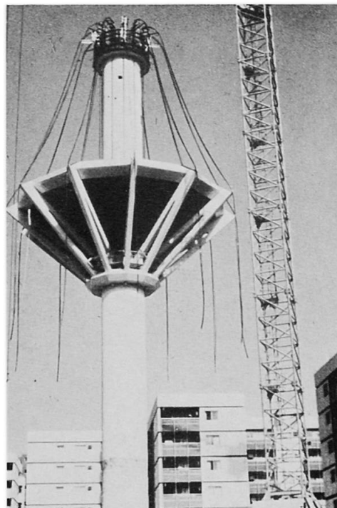
Bild 9 Der Hochbehälter wird gehoben
