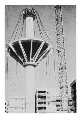
Bild 9 Der Hochbehälter wird gehoben
