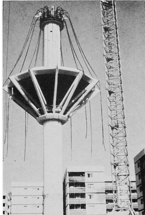
Bild 9 Der Hochbehälter wird gehoben
