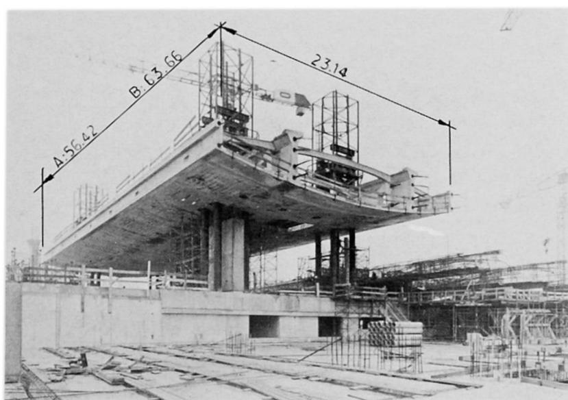
Les éléments porteurs essentiels de cette structure en béton léger précontraint sont les deux poutres principales de 3.44 m de hauteur dont l'épaisseur varie de 0.40 m en travée à 0.80 m sur appui. Ces deux poutres parallèles sont distantes de 11.90 m d'axe en axe.
