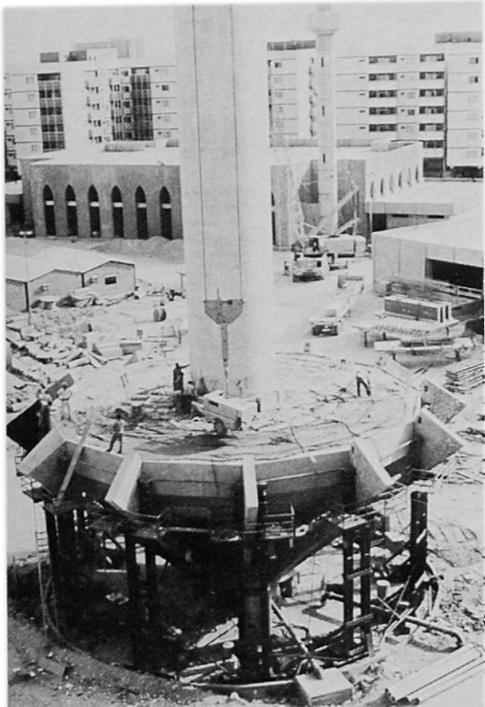
Bild 8 Der Hochbehälter nach Abschluß der Betonierarbeiten
