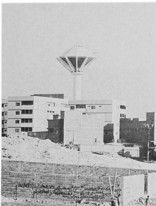
Die Behälterdecke erhielt gegen Oberflächenwasser eine Dichtung mit Gehbelag. Für den Schutz des Behälters gegen Sonneneinstrahlung dient eine dachförmige Aluminiumabdeckung. Für Kontroll- und Wartungszwecke ist zwischen den Streben ein Umgang angeordnet.
