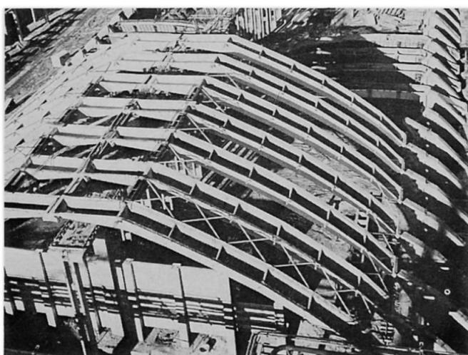
Fig.2. The longitudinal stiffening system
