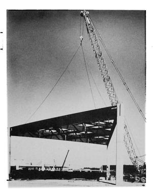
Bild 11: Montage eines dreieckförmigen Trägerfeldes von 28 m Seitenlänge mittels Autokran
