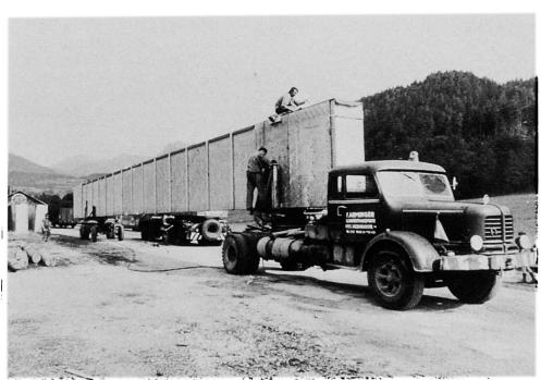
Bild 10: Straßentransport von 32 m langen Kastenträgern mit Sperrholzstegen
