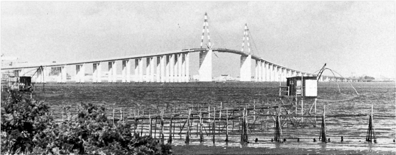
Figure 1 - Pont de SAINT-NAZAIRE
