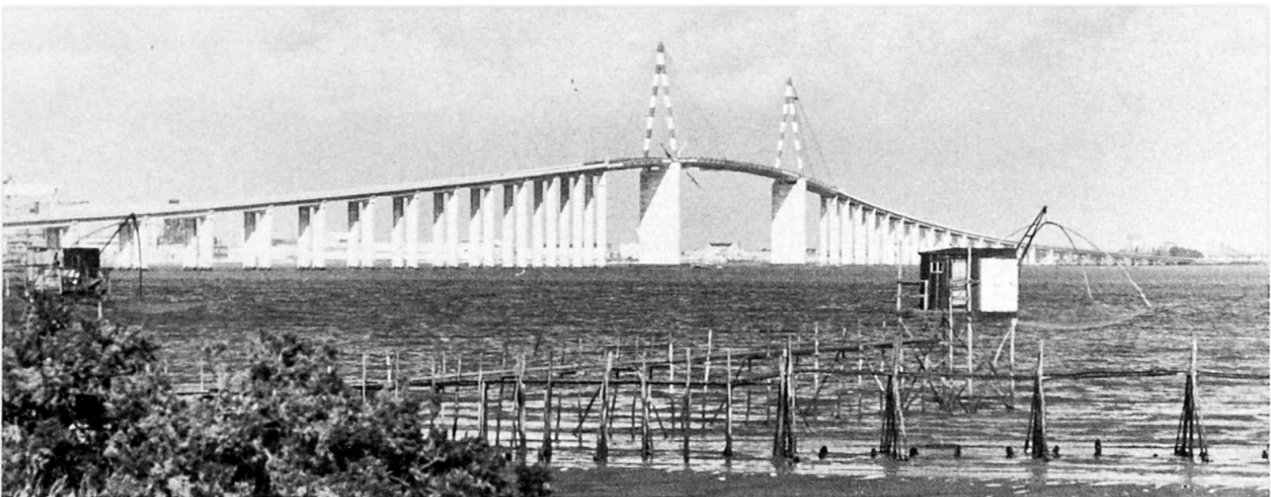
Figure 1 - Pont de SAINT-NAZAIRE
