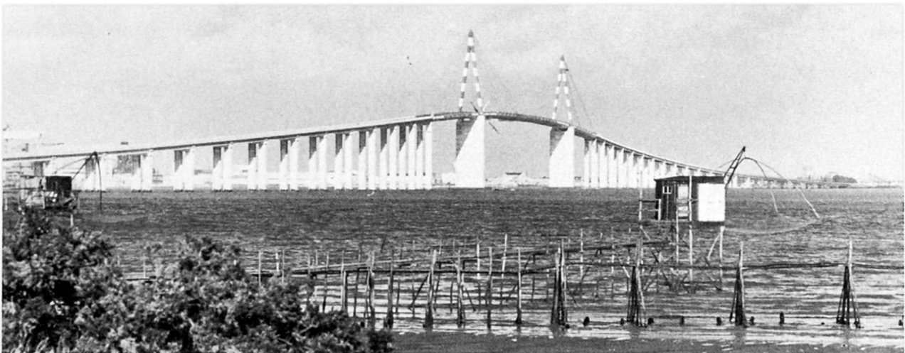
Figure 1 - Pont de SAINT-NAZAIRE
