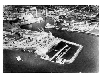
Finition de la digue d'enclôture du terre-plein après échouage du bassin et adjonction d'un caisson de quai.
