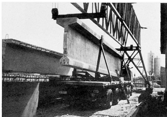
Bild 6: Trägeraufladung auf Transportmittel
