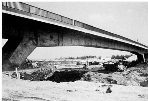
Pont de Bruyères-sur-Oise
