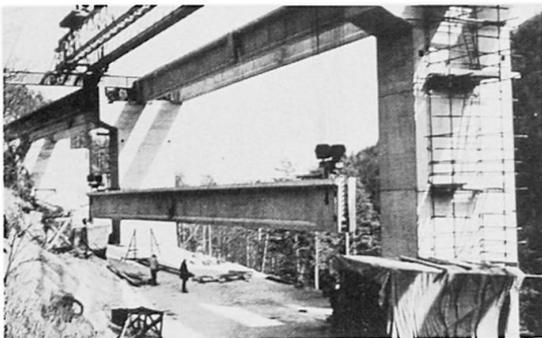
Bild 10: Konstruktion für die Montage der Träger über die Klebepiste der Stirnflächen dem Epoxi-Kleber und das Zusammenpressen durch die hydraulischen Pressen. Nach dem Vorspannen der ersten Kabelphase wird der Träger mit der Montagekonstruktion gehoben, auf das Montagefeld transportiert und auf die Neoprenlager versetzt.
