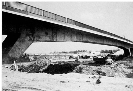
Pont de Bruyères-sur-Oise
