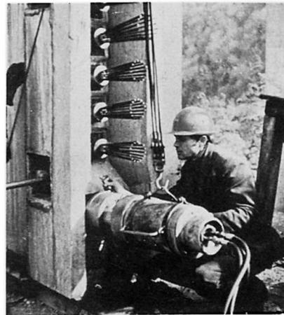
Bild 9: Vorspannen von IMS Vorspannkabels
