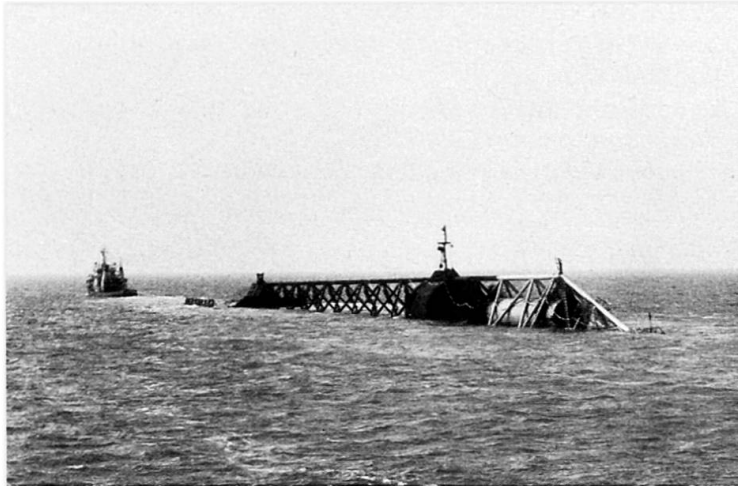
Figure 1 - Colonne articulée en cours de remorquage
