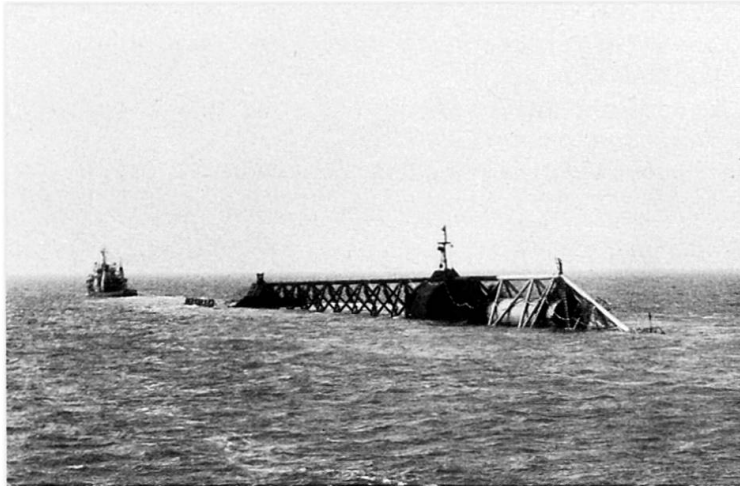
Figure 1 - Colonne articulée en cours de remorquage
