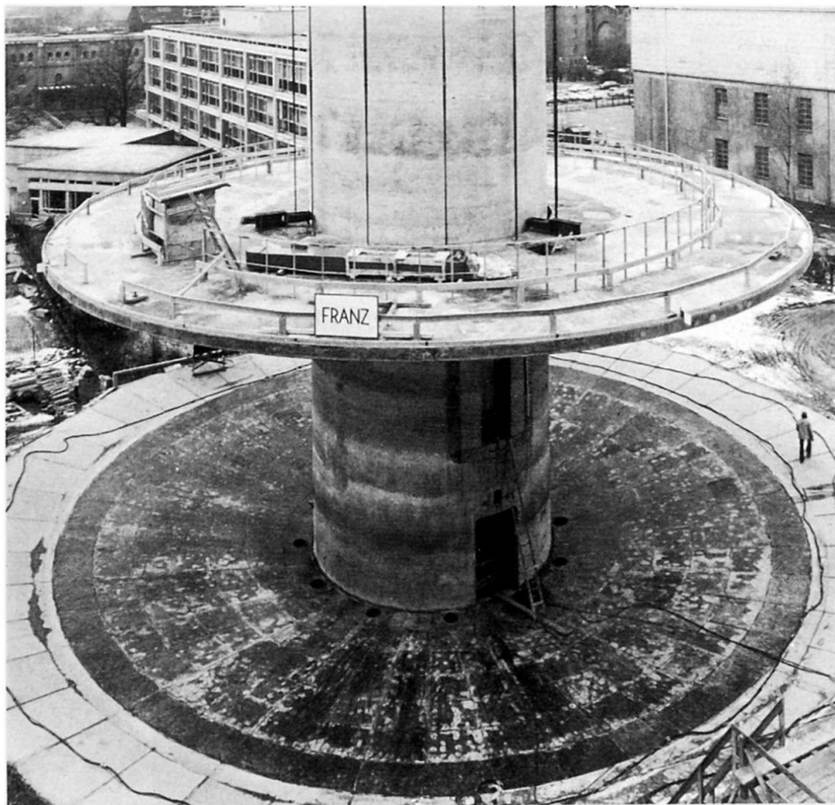
ANHEBEN DER PLATTFORMEN BEIM RICHTFUNKTURM ARSENAL
