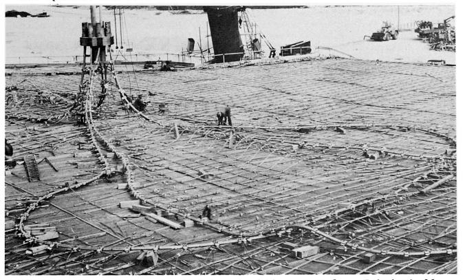
Bild 10: Zusammenbau der Netzkonstruktion am Boden, Schwimmhalle
