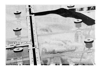
Bild 9: Acrylglas-Dachhaut mit Fugenausbildung und Pufferauflagerung auf den Netzknoten
