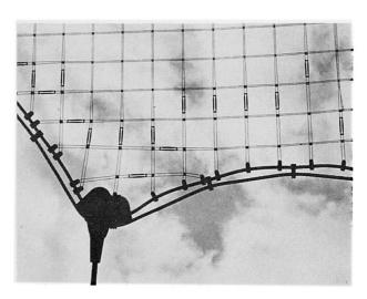
Bild 7: Netzpartie mit Spannschlössern, Randseilklemmen, und Randseil aus 2 gekoppelten Einzelseilen
