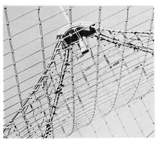
Bild 8: Netzpartie mit über einem aufgehängten Knotenpunkt umgelenkten Randseilen
