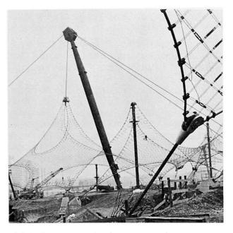
Bild 5: Ausschnitt aus den Zwischenbereichsdächern (ohne Dachhaut)
