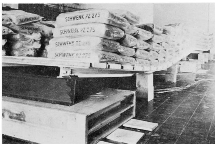
Bild 5: Versuch mit Flachsspanplatten; Pfetten IPE 100 über 2 x 5,50 m gestützt; horizontales Dach ohne Zugstangen
