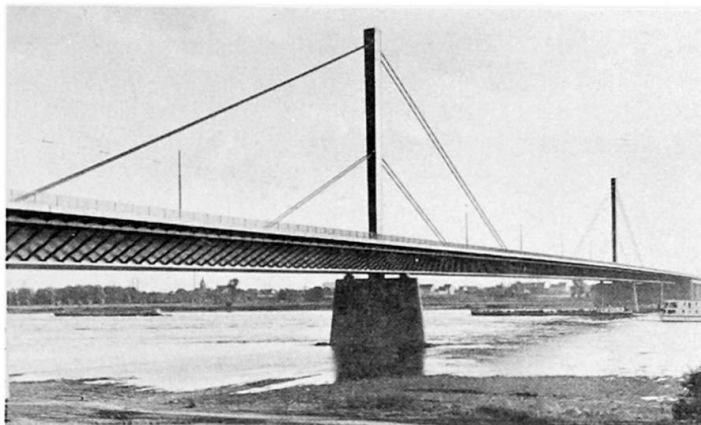
Bild 5: Rheinbrücke Leverkusen; einwandige Schrägseilbrücke
