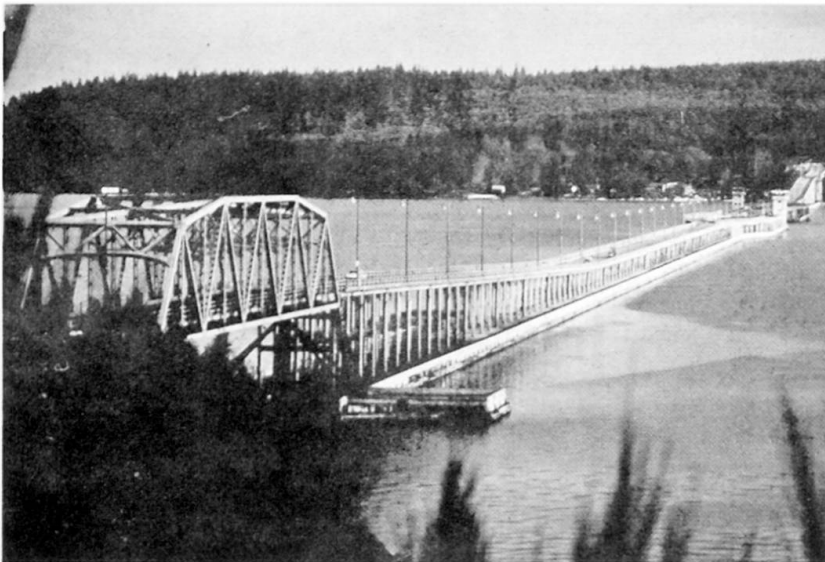
Abb. 1 zeigt als Beispiel für eine "schwimmende Balken-Brücke" die Brücke über den Hood-Kanal in den USA.
