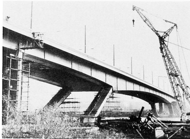
Bild 3. und Bild 4. Die Montage der Brücke
