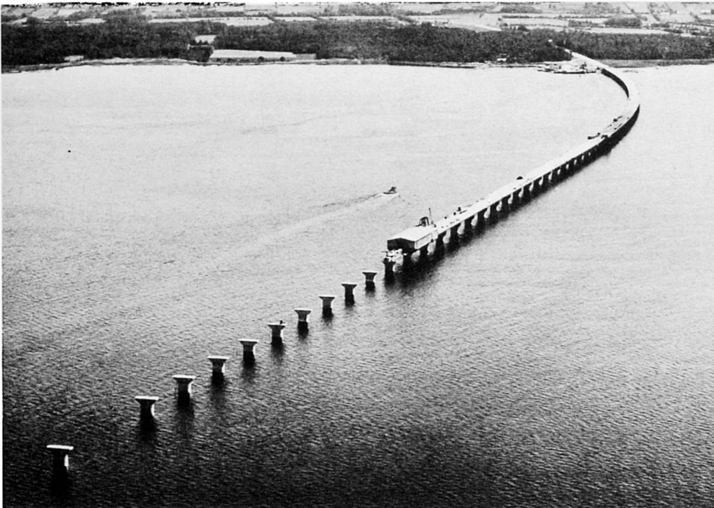
Das Vorschubgerüst auf der Ölandseite
