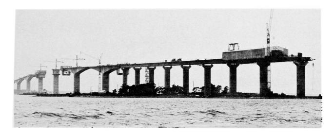
Die Plattenbalkenteile werden im Taktverfahren mit Vorschubrüstung feldweise gebaut. Die Anzahl der Felder ist auf der Festlandseite 23 und auf der
