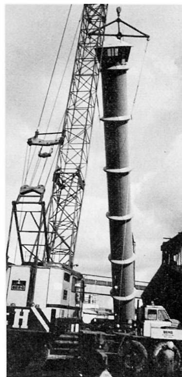
Montage des GFK-Ansaugkamines, Abb. 11
