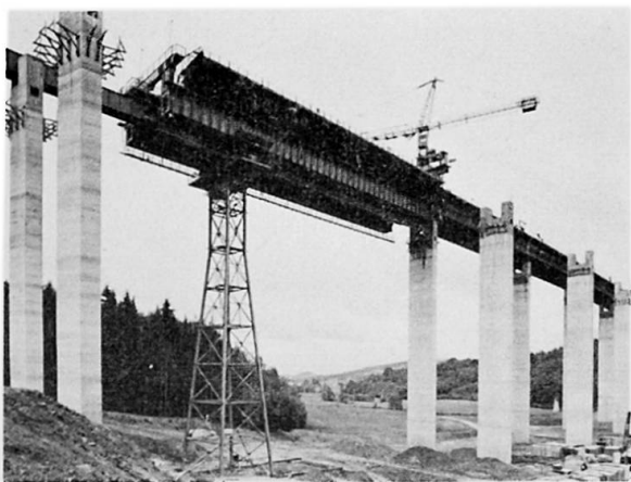
Bild 14 Döllbachtalbrücke Vorschubrüstung im großen Feld mit Zwischenstütze
