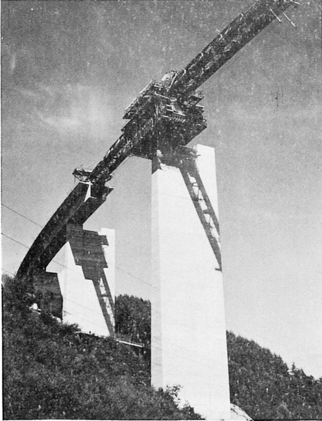
Bild 16 Siegtalbrücke Eiserfeld - Vorschubrüstung für Spannweiten über 100 m
