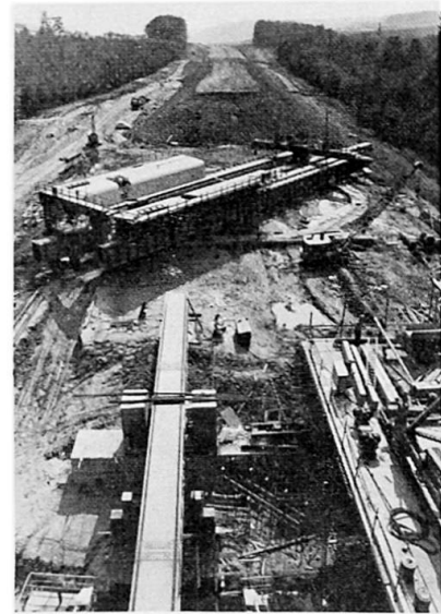
Bild 5 Drehen einer Vorschubrüstung hinter einem Widerlager
