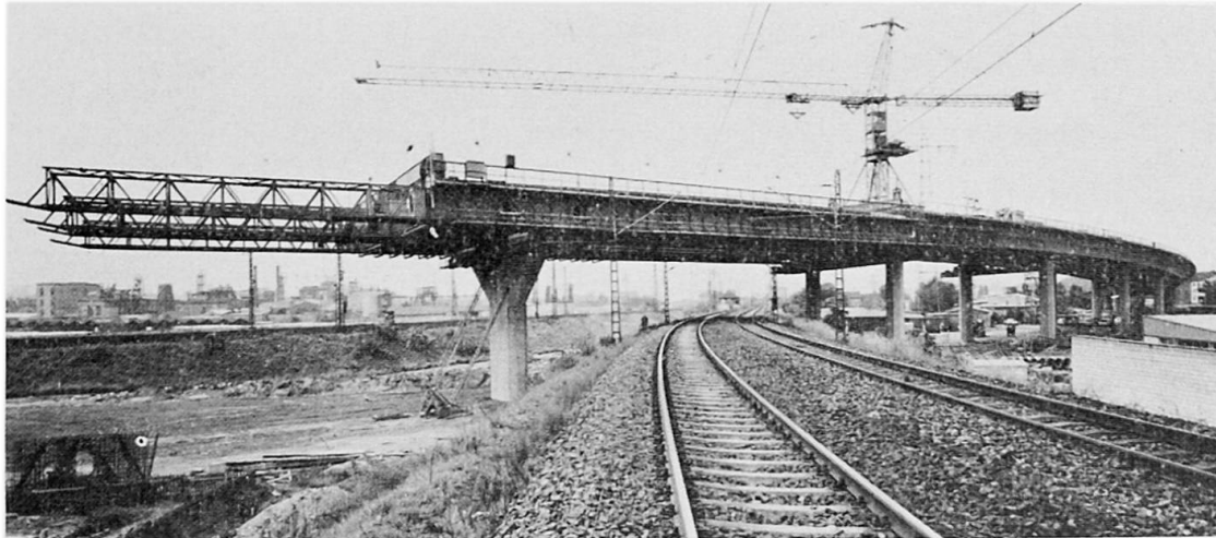
Bild 13 Stadtkerntangente Mainz Vorschubrüstung kreuzt eine Eisenbahnlinie
