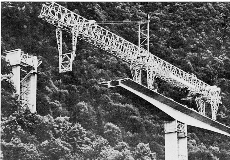
Bild 22 Hangbrücke Chillon - Bauzustand
