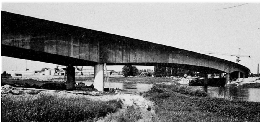
Bild 11 Weserbrücke Minden Zweistegiger Plattenbalken mit 100 m Spannweite
