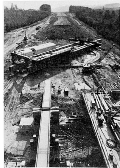
Bild 5 Drehen einer Vorschubrüstung hinter einem Widerlager
