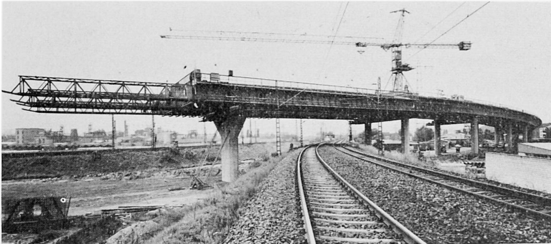
Bild 13 Stadtkerntangente Mainz Vorschubrüstung kreuzt eine Eisenbahnlinie
