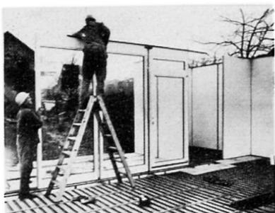
Bild 10: Stahl/PU-Sandwichwandtafeln
