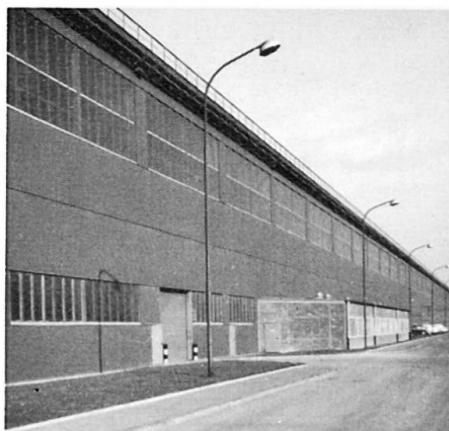
Bild 12: Stahl/PU-Sandwichwandtafeln für Industriehallen
