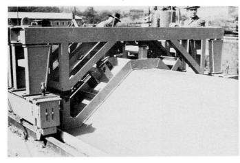
Bild 8 Aggregat zum Verteilen, Verdichten und Glätten des Betons
