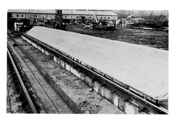
Bild 7 Stahlbeton-Matrize zur Fertigung von VT-Falten
