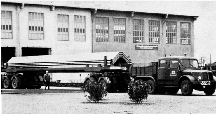
Bild 10 Transport einer VT-Falte
