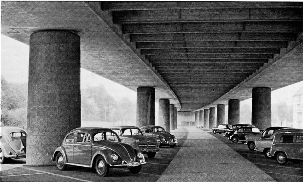
Fig. 19. Rampe zur Nordbrücke in Düsseldorf, Deutschland.
