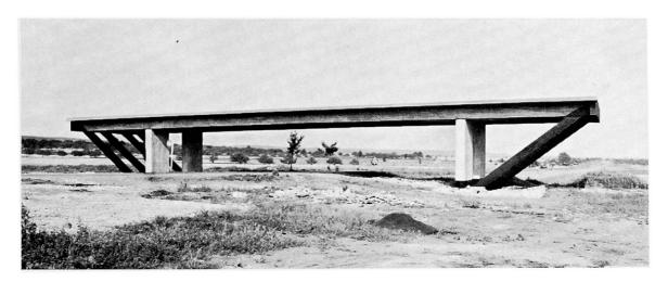
Fig. 36a. Rahmenbrücke nach Bild 36 über die Autobahn bei Wiesbaden, Deutschland, vor dem Schütten der Dämme.
