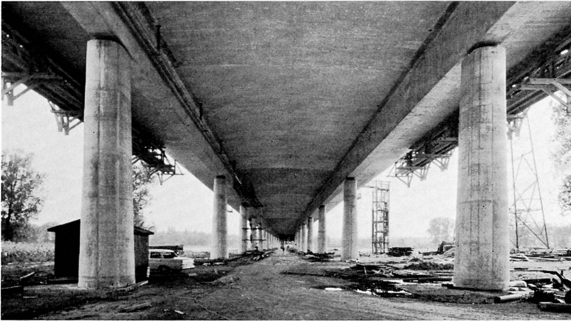
Fig. 41. Unter der Brücke nach Fig. 40, hergestellt mit fahrbarem Gerüst.
