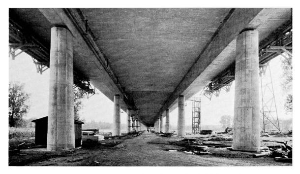
Fig. 41. Unter der Brücke nach Fig. 40, hergestellt mit fahrbarem Gerüst.
