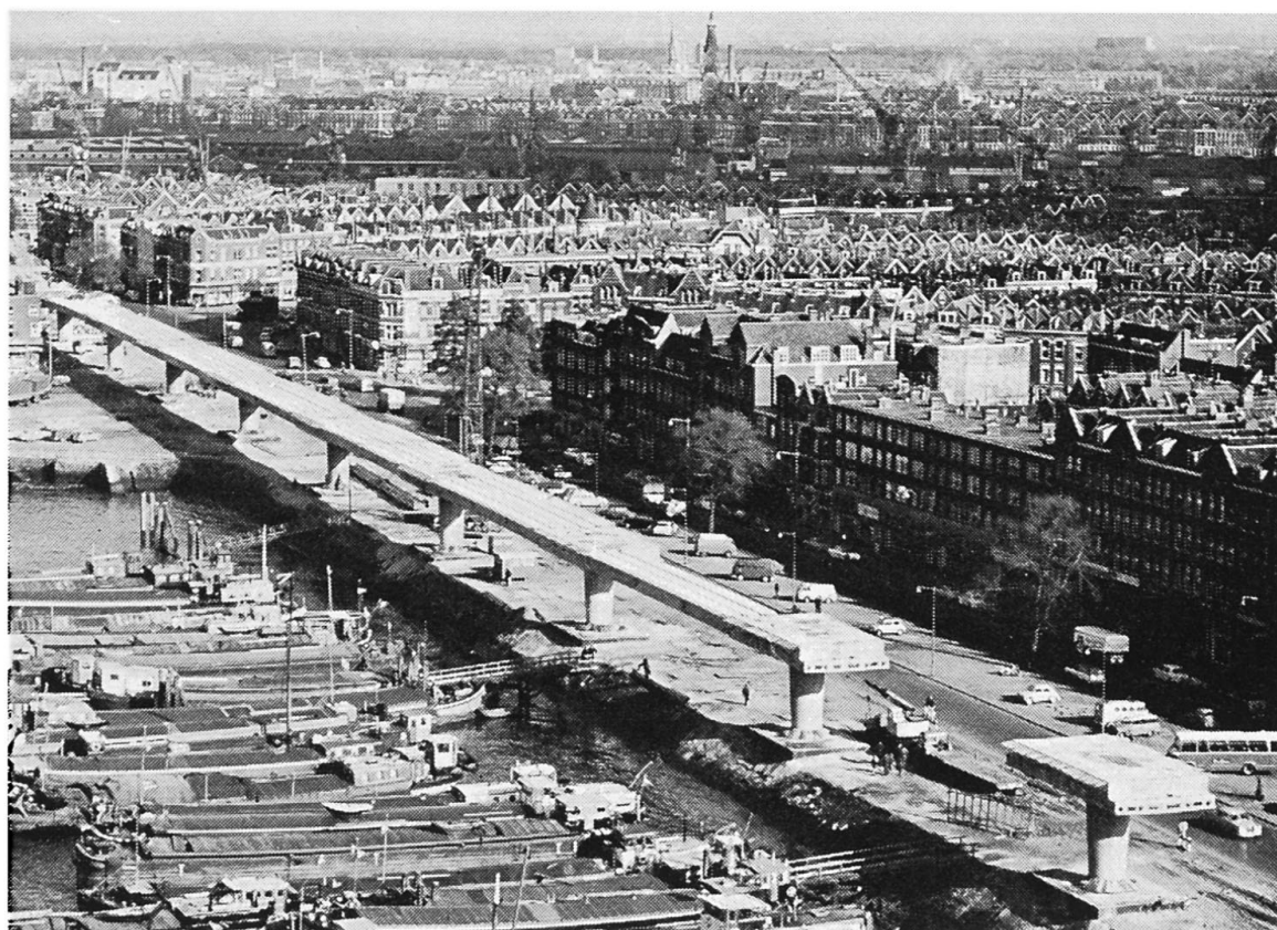
Fig. 23. Auflagerung vorgefertigter Balken auf einer in die Stütze eingespannten Tischplatte beim Metro-Viadukt in Rotterdam, Niederlande [21].
