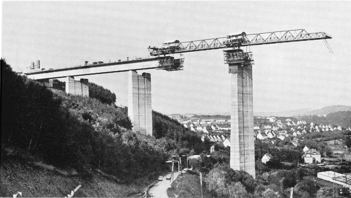
Fig. 29. Siegtalbrücke der Autobahn bei Eiserfeld, Deutschland [31].
