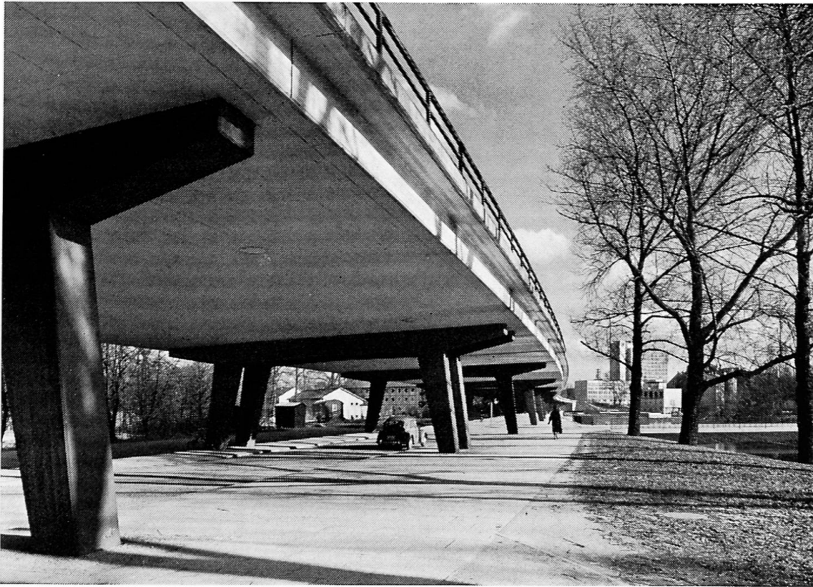
Fig. 18. Hochstraßenbrücke Fischerstraße in Hannover, Deutschland.
