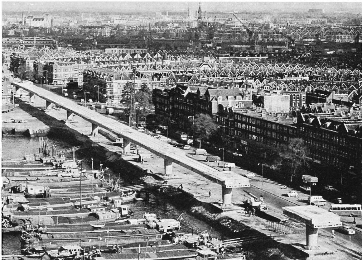
Fig. 23. Auflagerung vorgefertigter Balken auf einer in die Stütze eingespannten Tischplatte beim Metro-Viadukt in Rotterdam, Niederlande [21].
