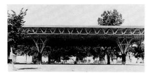
Fig. 20. Roof Space Frame
