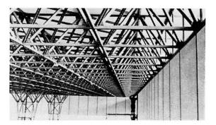
Fig. 19. Roof Space Frame
