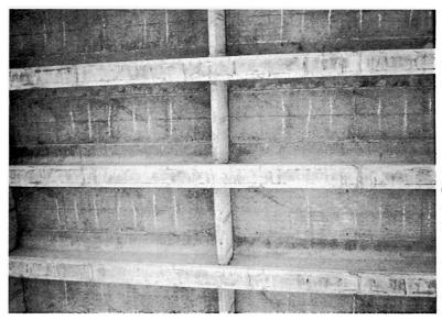
Fissures dans un hourdis coulé en place entre poutres préfabricuées. Photographie S.S.A.R.
