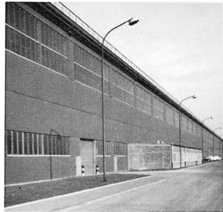
Bild 12: Stahl/PU-Sandwichwandtafeln für Industriehallen
