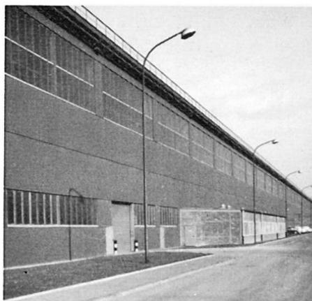
Bild 12: Stahl/PU-Sandwichwandtafeln für Industriehallen
