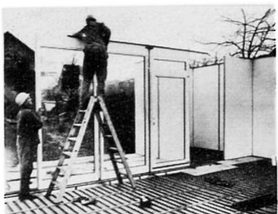
Bild 10: Stahl/PU-Sandwichwandtafeln
