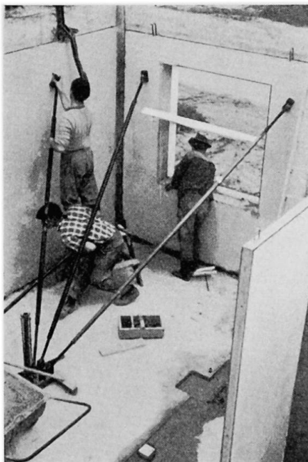
Fig. 10. Montagehalterung nach O. PLATZER (Berlin) (Pat. ang.) [8].
