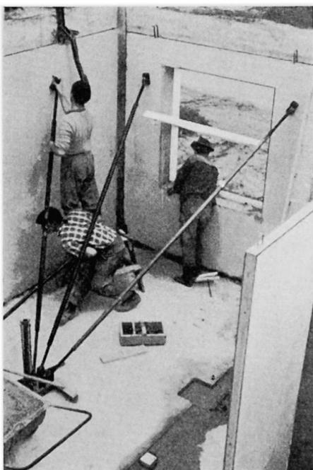
Fig. 9. Justiereinrichtung für Wandplatten auf einer Wohnungs-Baustelle in Hamburg [7].
