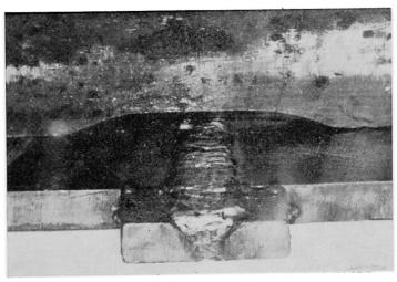
Fig. 11. Einzelheit zu Fig. 8. CO<sub>2</sub>-geschweißte Decklage des Untergurtstoßes.
