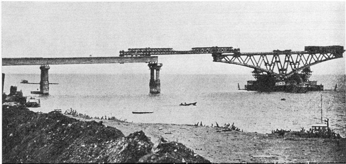
Fig. 4. Das Raumfachwerk wird mit dem schon früher aufgestellten Raumfachwerk durch einen Schnabel verbunden.
