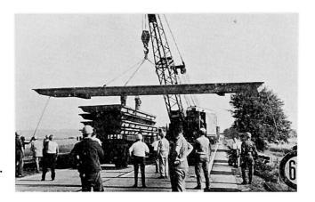
Fig. 6. Montage der Stahlflachstraße.
