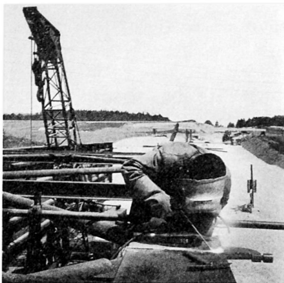
Fig. 5. Soudure au montage de la semelle supérieure.
