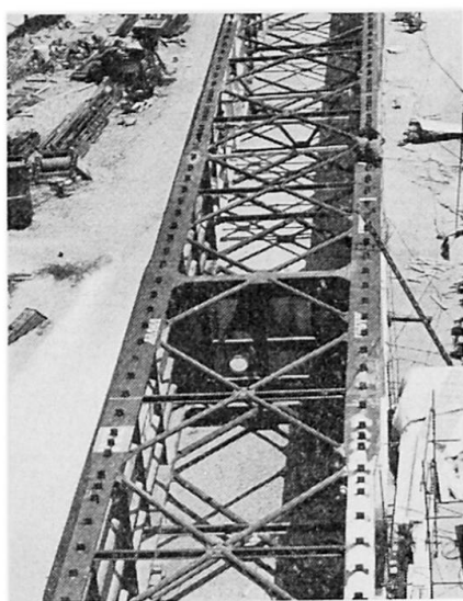
Fig. 3. Tronçons sur pile en montage.
