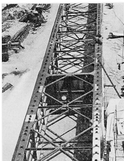
Fig. 3. Tronçons sur pile en montage.
