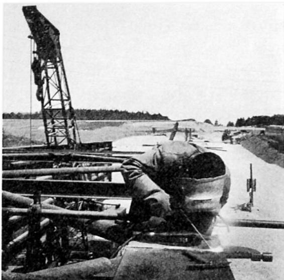
Fig. 5. Soudure au montage de la semelle supérieure.
