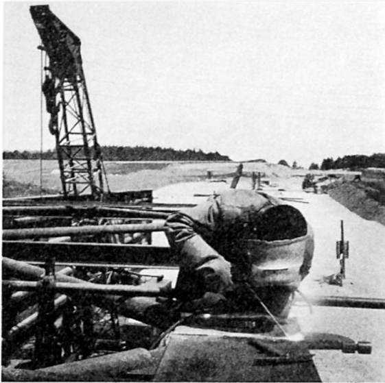
Fig. 5. Soudure au montage de la semelle supérieure.
