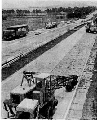
Fig. 3. Stahlflachstraße neben der Reparaturstrecke auf der Europastraße 4 Frankfurt-Hannover.
