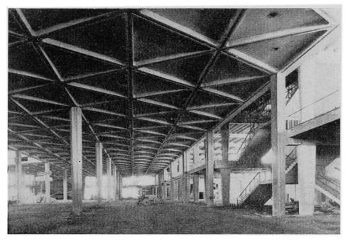
Fig. 22 et 23 - Palais du Centre National des Industries Techniques (CNIT au Rond Point de la Défense, Paris). Plancher central de 11.000 m² constitué de 1400 dalles triangulaires de 6 m de coté assemblées sur place par précontrainte en groupes de 9. Eléments préfabriqués à Nanterre et amenés par remorques routières (Balency, Boussiron, Coignet).
