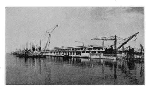
Fig. 19 - Gare maritime du Havre 1952. Fabrication à Rouen à 90 km du chantier - transport par wagons - 1600 éléments de 12,50 x 2,00 pesant 12 t. Poutres maîtresses fabriquées par tronçons. Poutres support de shed de 20,00 m et pesant 26 t. Assemblage par précontrainte (Campenon Bernard).
