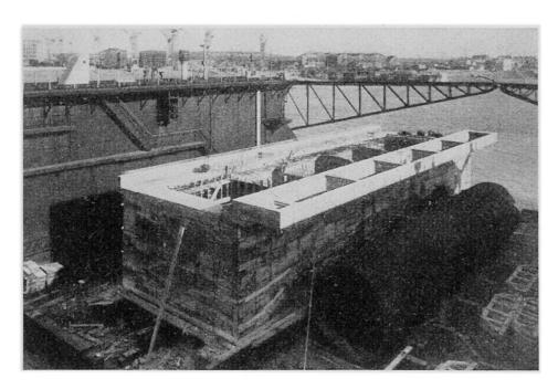
Fig. 32 - Caisson du quai d'armement de Dunkerque muni de ses flotteurs auxiliaires, avant sa mise à l'eau (Sainrapt et Brice).
