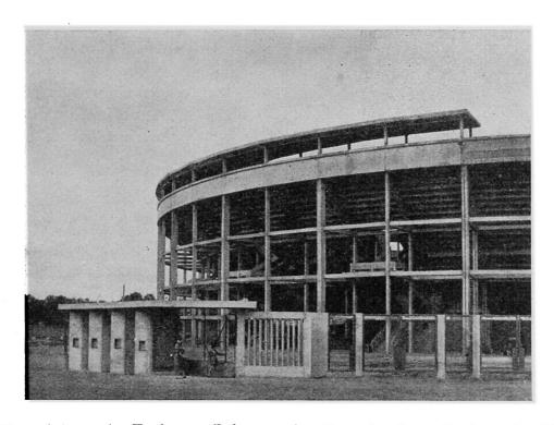
Fig. 18 - Arènes de Toulouse: Polygone de 48 cotés d'un diamètre de 94 m - 12.500 places. Raidisseurs, crémaillères et gradins préfabriqués (Cofeba).
