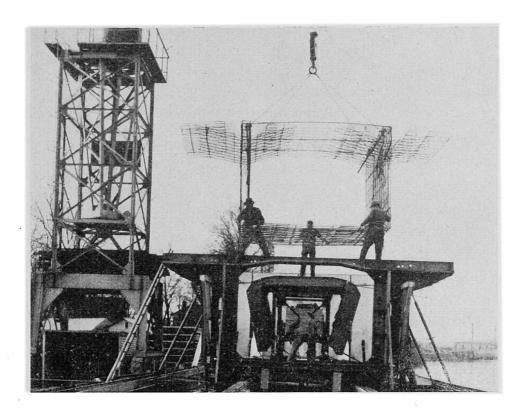
Fig. 26 - Pont de Choisy-le-Roi. Mise en place d'un ferraillage de voussoir préfabriqué (Campenon - Bernard).
