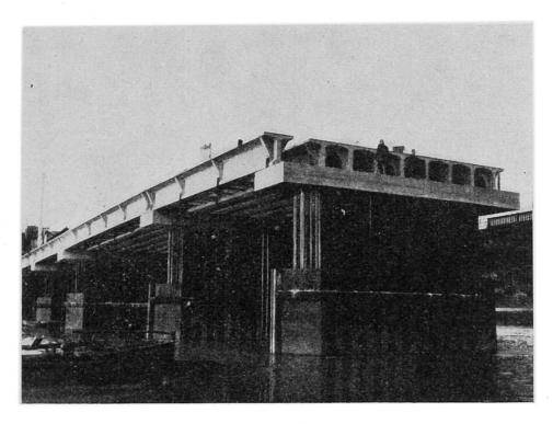
Fig. 24 - Pont provisoire de Courbevoie en poutres préfabriquées solidarisées par précontrainte (Campenon - Bernard).
