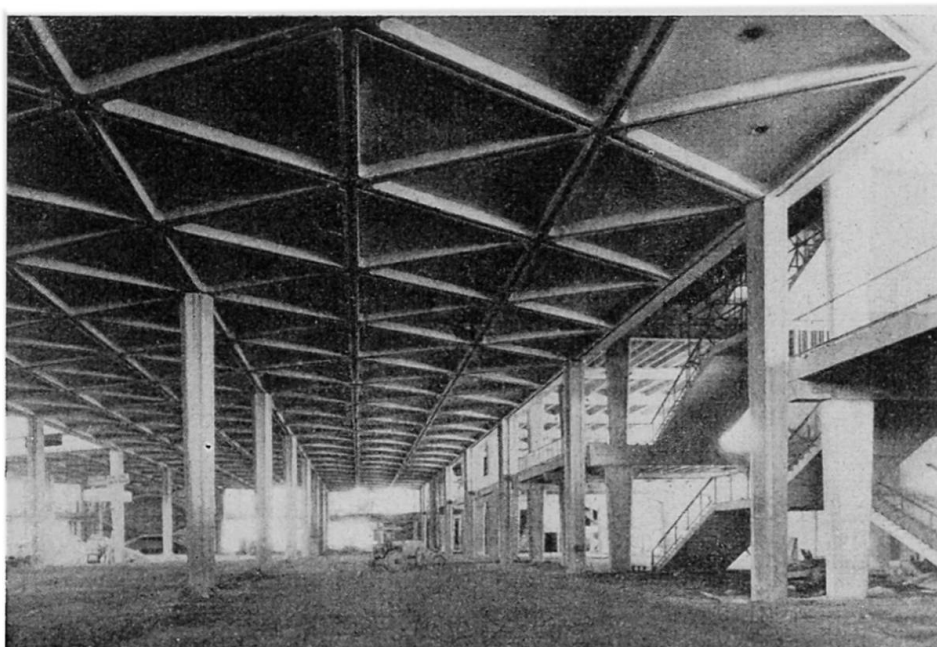
Fig. 22 et 23 - Palais du Centre National des Industries Techniques (CNIT au Rond Point de la Défense, Paris). Plancher central de 11.000 m 2 constitué de 1400 dalles triangulaires de 6 m de coté assemblées sur place par précontrainte en groupes de 9. Eléments préfabriqués à Nanterre et amenés par remorques routières (Balency, Boussiron, Coignet).
