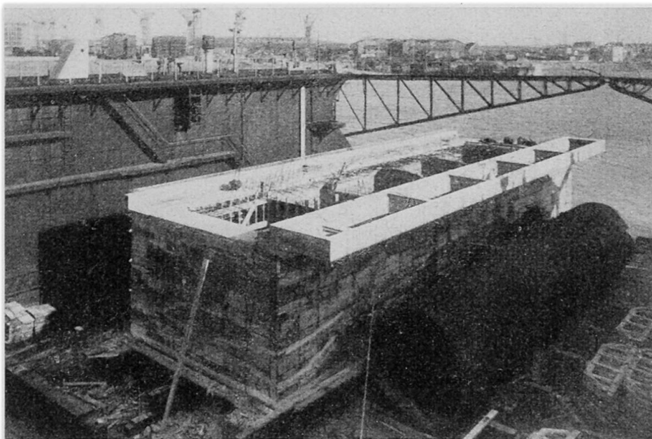
Fig. 32 - Caisson du quai d'armement de Dunkerque muni de ses flotteurs auxiliaires, avant sa mise à l'eau (Sainrapt et Brice).
