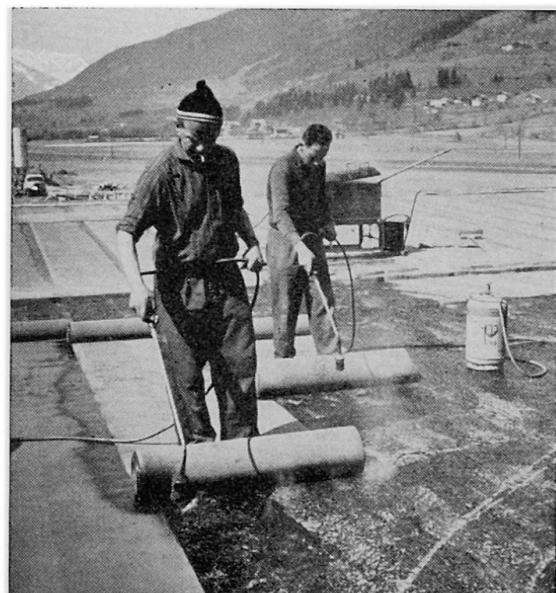
Fig. 1. Bitumen-Isolierungen nach dem Flämmverfahren.
