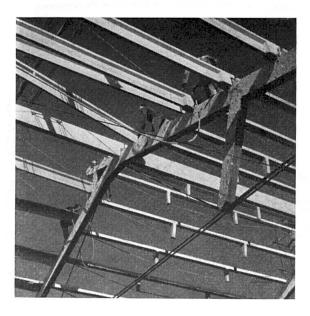
Fig. 14. Assemblage des pannes aux éléments principaux.
