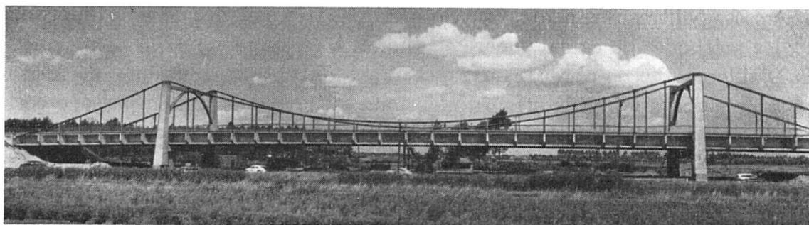
La précontrainte a été obtenue par le soulèvement au-dessus des piles et au moyen de vérins hydrauliques des portiques qui supportent les câbles installés sans tension initiale et qui sont indépendants du tablier. Celui-ci ne comporte dans son épaisseur aucun câble de précontrainte.
