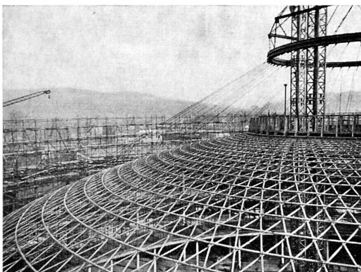
Fig. 4. Hochziehen des fertigen Teiles der Gitterschale.
