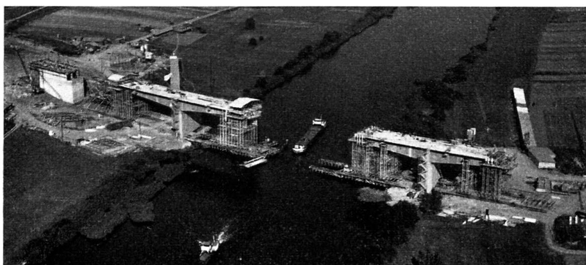
Fig. 4. Bauzustand. 1. Überbau.
