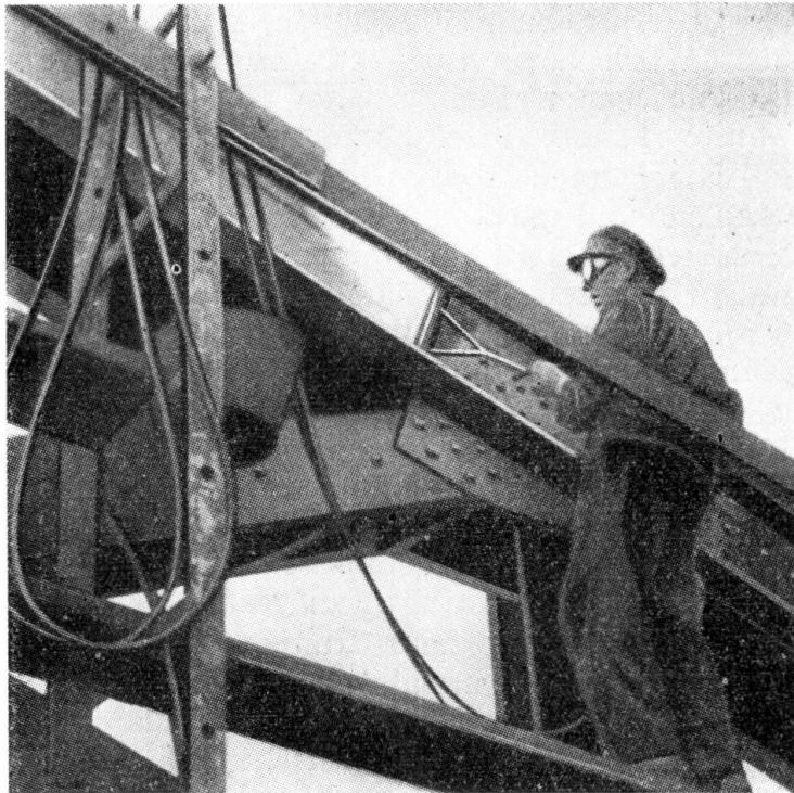
BILD 2. Flammstrahlen einer Brücke. Brennerbreite 300 mm
