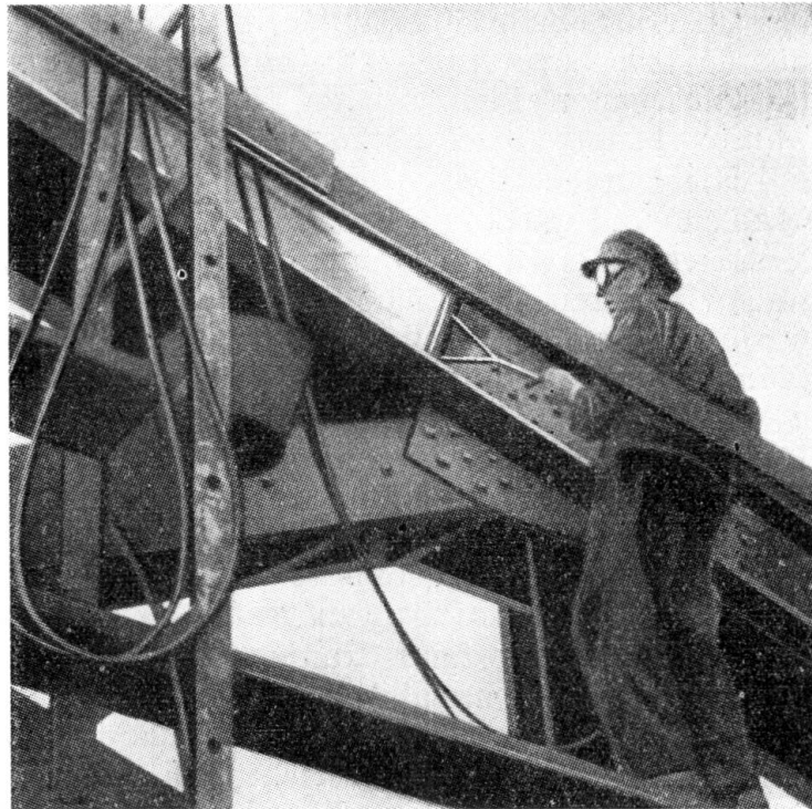
BILD 2. Flammstrahlen einer Brücke. Brennerbreite 300 mm
