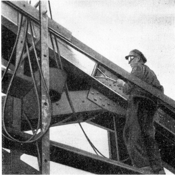
BILD 3. Flammstrahlen einer Brücke. Brennerbreite 300 mm
